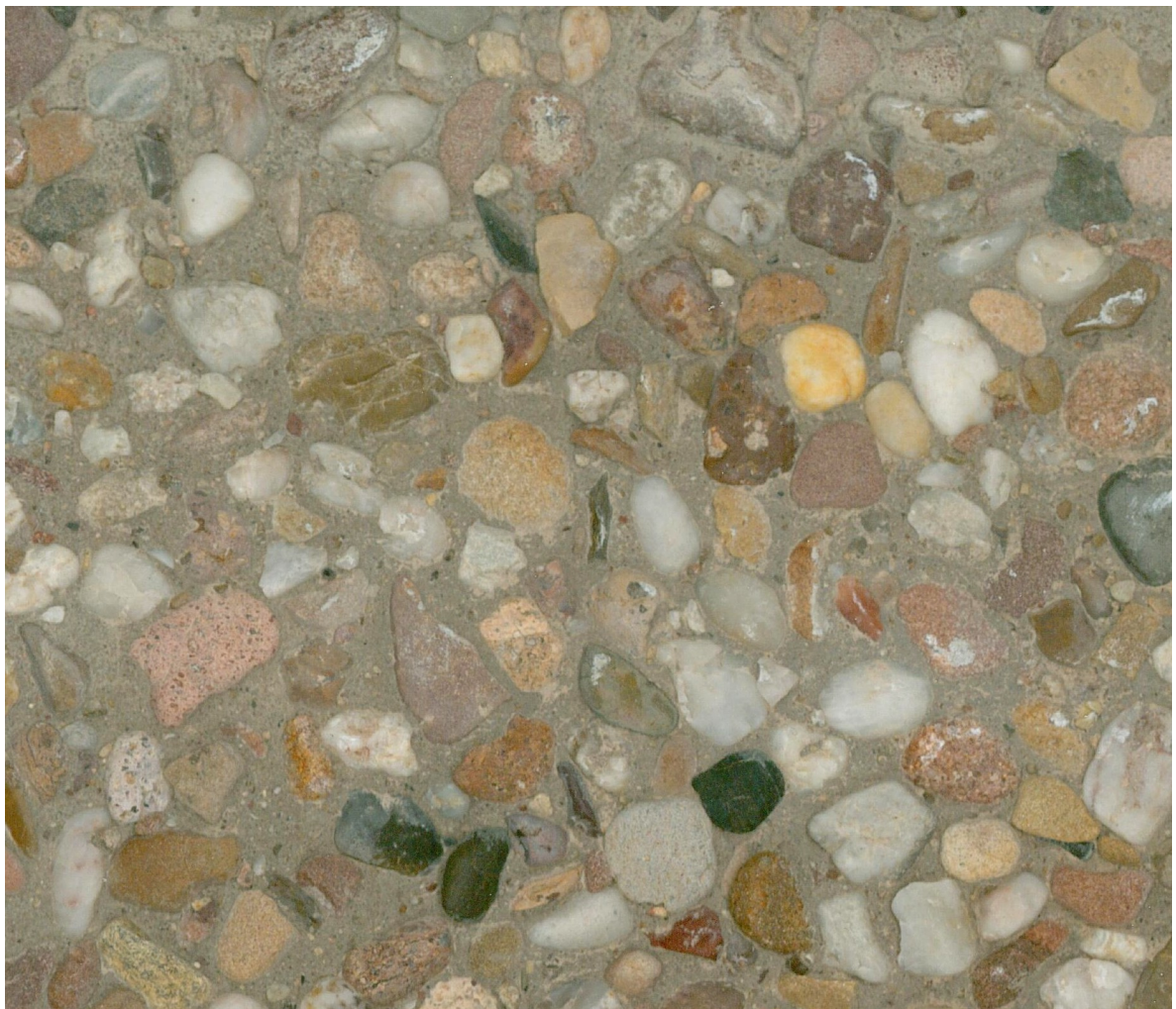
Waschbeton dunkel (rötlich)
